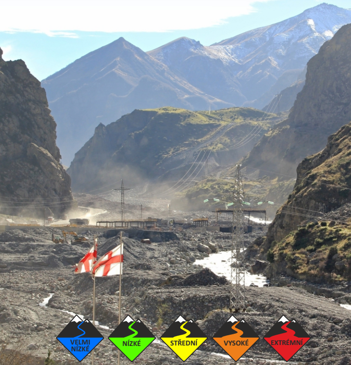
Výstavba vodní elektrárny Larsi v Soutěsce Daňali. Vít Baldík
