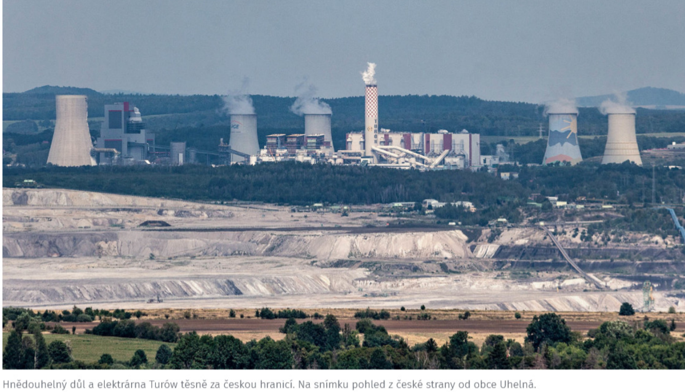
Hnědouhelný důl a elektrárna Turów těsně za českou hranicí. Na snímku pohled z české strany od obce Uhelná. autor: HN - Václav Vašků
