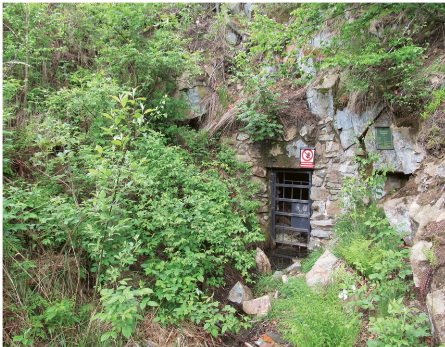
Obr. 17. Portál odvodňovací štoly dolu Schweidrich.
