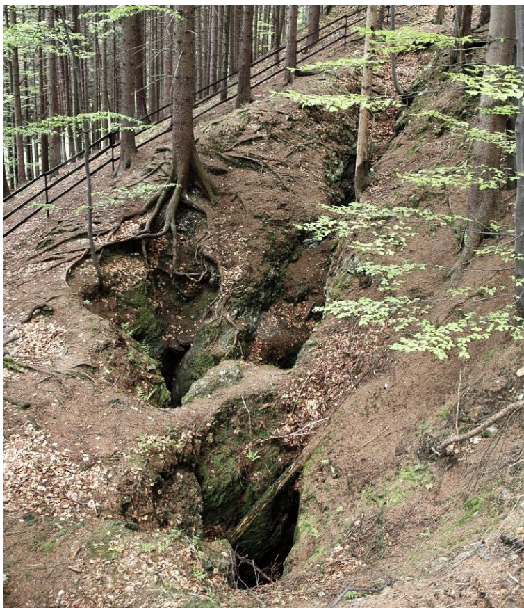
Obr. 8-27. Štola Marie Pomocná, vstup do štoly (foto www.kr-olomoucky.cz )
