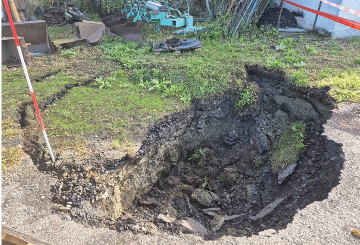
➤ Propad jámy Chvalovického dolu po těžbě grafitu ve Chvalovicích u Netolic, okres Prachatice. Řešeno v rámci Registru starých důlních děl.
