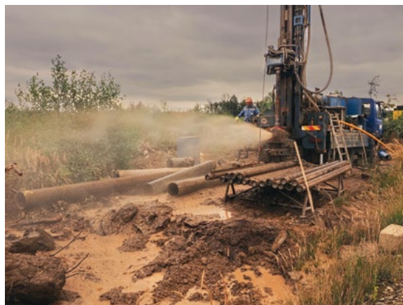
« Práce na hydrogeologickém vrtu Bohdalov v rámci projektu Podzemní voda v krystaliniku . Foto R. Hadacz.
