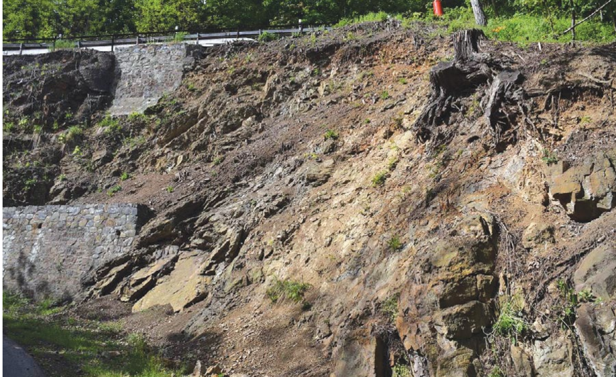
⚡ Nestabilní skalní svah pod silnicí II/2421 v Roztokách u Prahy. Foto J. Novotný, 2025.
