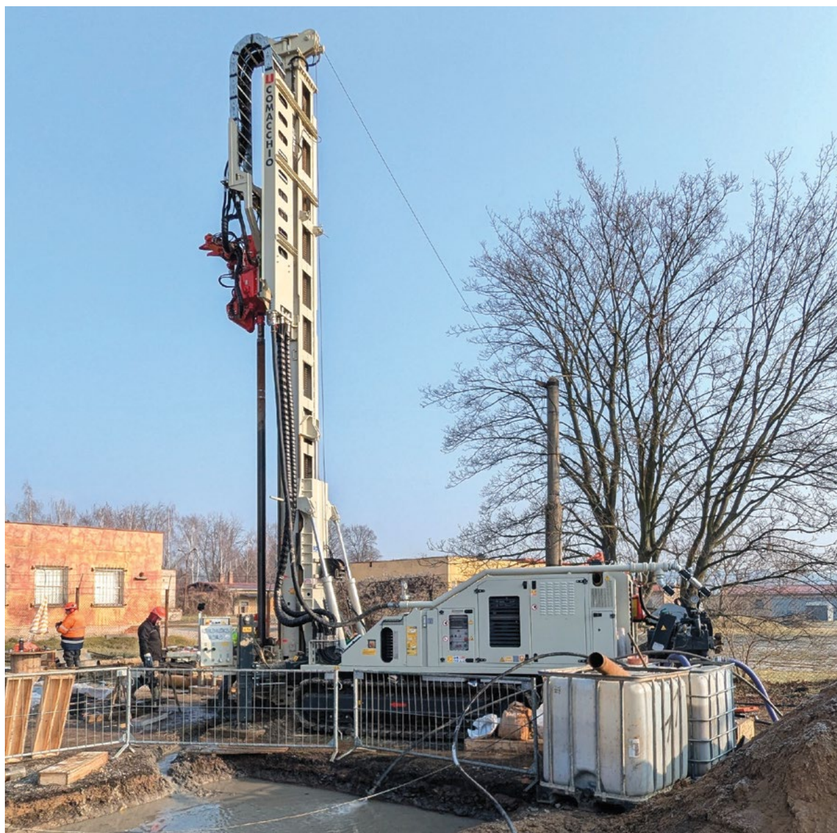
⚡ Vrtání 500 m hlubokého jádrového vrtu na lokalitě v Litoměřicích za účelem geologického popisu zkoumaného území budoucího BTES pole. Foto J. Holeček.
