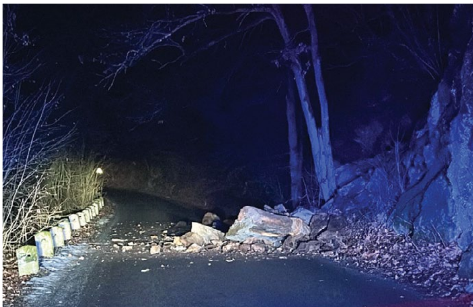
« Skalní řícení na silnici II/201 v úseku mezi Nezabudickým mlýnem a kempem Višňová. Foto KSUS Středočeského kraje, 2025.
