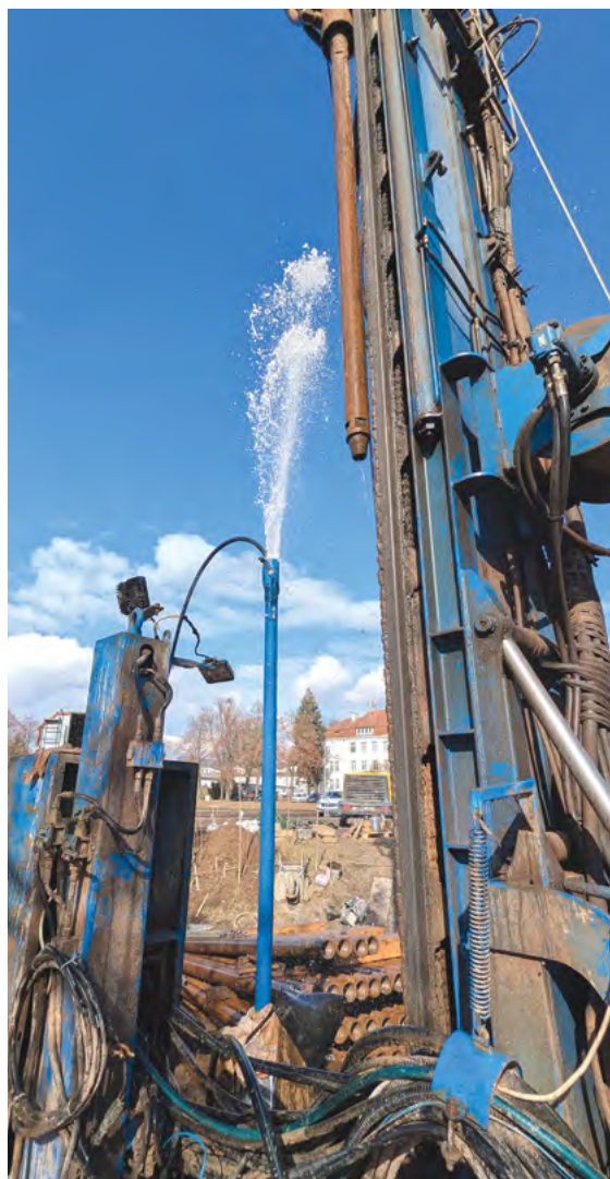
Čištění vrtného výplachu v hydrogeologickém vrtu LTH-1. Tento vrt bude sloužit pro hydrogeologický monitoring BTES pole na lokalitě v Litoměřicích. Foto J. Holeček.
