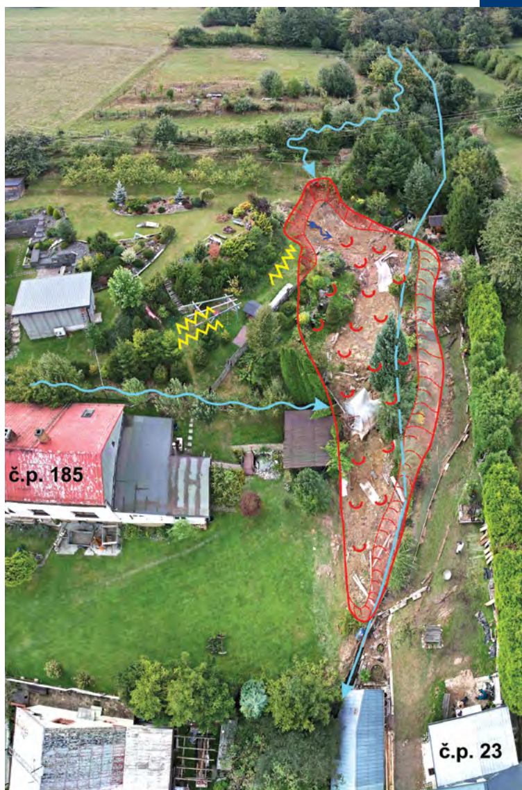
Schematická situace nestabilního svahu u nemovitosti č. p. 23 na břehu Mýslíkovského potoka v k. ú. Myslík s pohledem k západu, na podkladu leteckého snímku pořízeného ČGS dne 19. září 2024. Foto J. Malík, září 2024.
