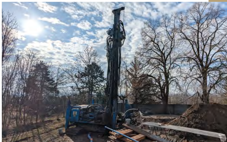
Čištění vrtného výplachu v hydrogeologickém vrtu LTH-1. Foto J. Holeček.
