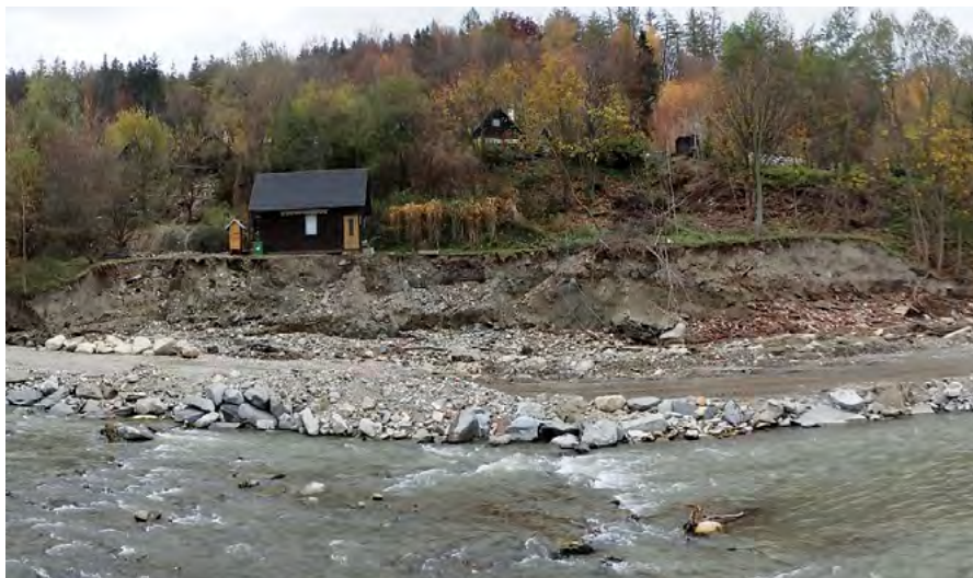
Odplavená akumulční část sesuvu ve Vrbně pod Pradědem po povodních v září 2024. Foto O. Krejčí.
