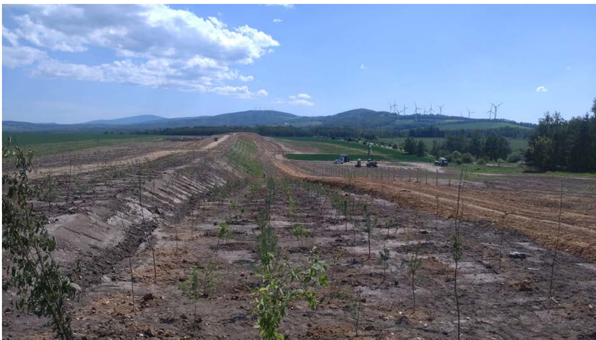
Obr. 3. Pohled na dokončený a osázený zemní val na jižním okraji dobývacího prostoru dolu Turów severně od osady Uhelná, v pozadí větrné elektrárny na české straně na Kamenném vrchu
