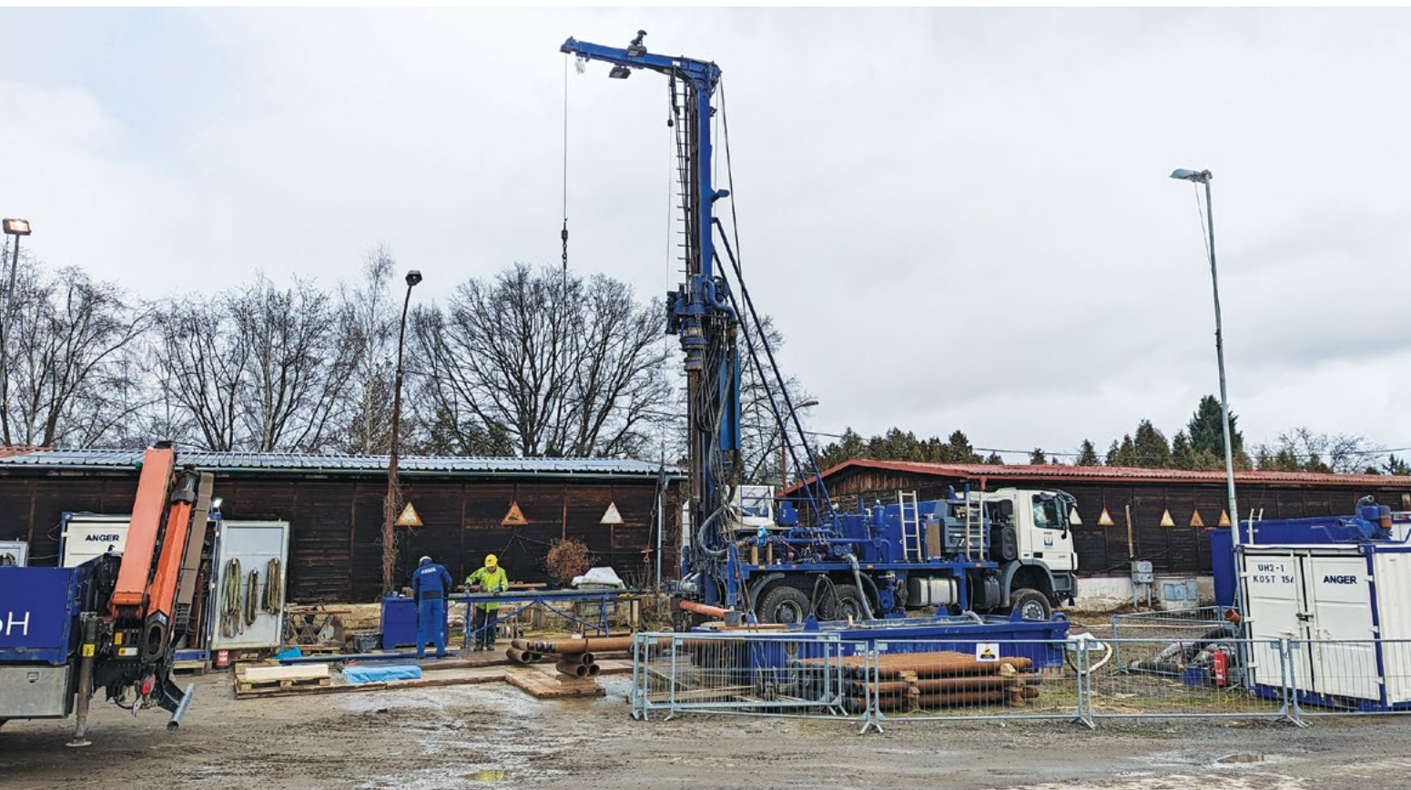
Vrtání 500 m hlubokého jádrového vrtu na lokalitě Litoměřice. Tento vrt je prvním průzkumným vrtem budoucího BTES úložiště. Foto J. Holeček.
