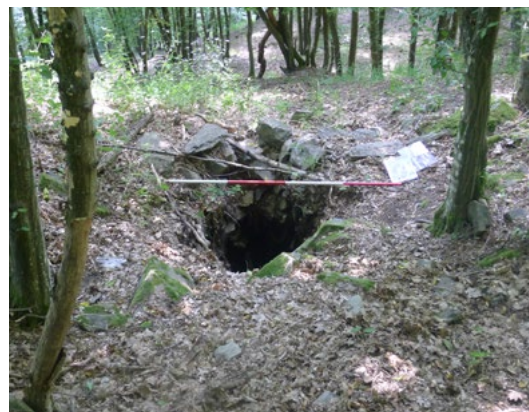
Propad na spodní štole pod Dušnem v lokalitě Hradištko pod Medníkem, okres Praha-západ. Řešeno v rámci Registru starých důlních děl.
