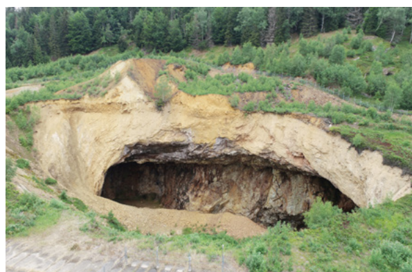
► Dokumentace skalního řízení na důlním propadu Žebračka v Heřmanovicích dronem ČGS. Foto J. Nečas.
