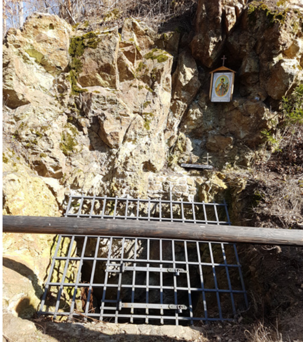
► Skalní výchoz nad potokem se zajištěnou šachticí, raženou do štoly sv. Jana v osadě Hamry u Hybrálce, okres Jihlava. Řešeno v rámci Registru starých důlních děl.
