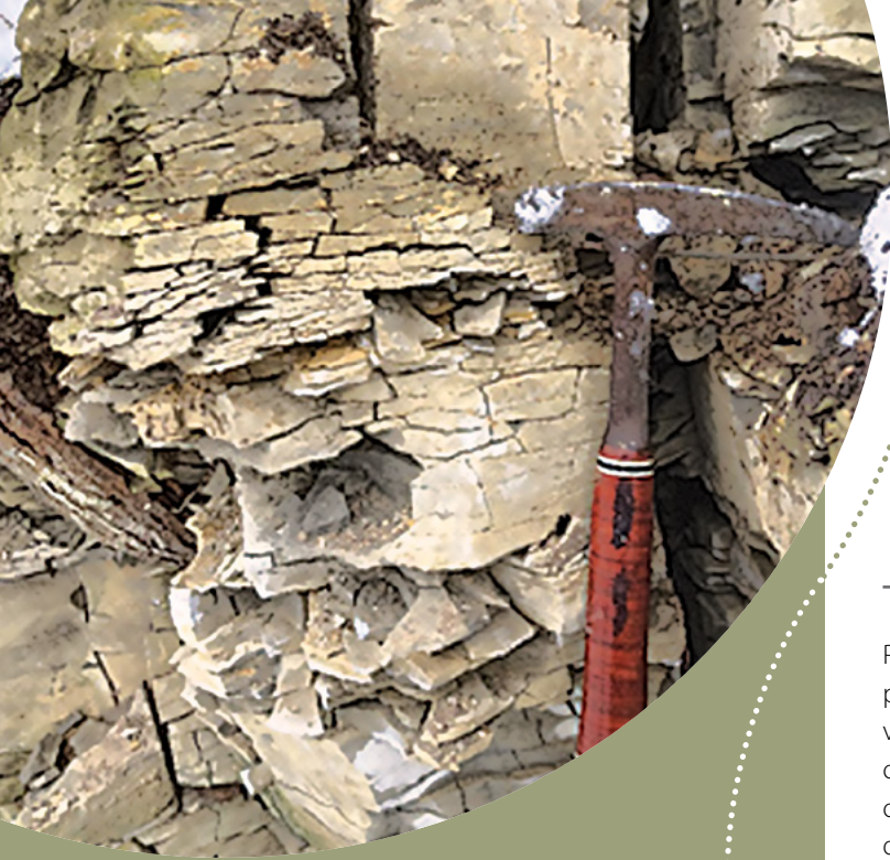
► Detail masivu slínovců jizerského souvrství postiženého skalním řícením pod kostelem sv. Jana Nepomuckého v Chmelíku.
