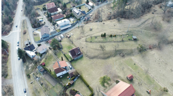
► Monitorování svahových deformací z roku 1997 dronem ČGS. Svahová deformace 25-32-05/82 Vsetín – Modlitebna. Foto J. Nečas.
