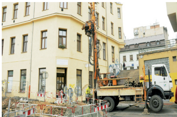
▲ Hloubení inženýrskogeologického vrtu s hloubkou do 30 m na chodníku v ulici Anenská v Brně pro zjištění hloubky odlučné plochy sesuvu. Foto O. Krejčí.
