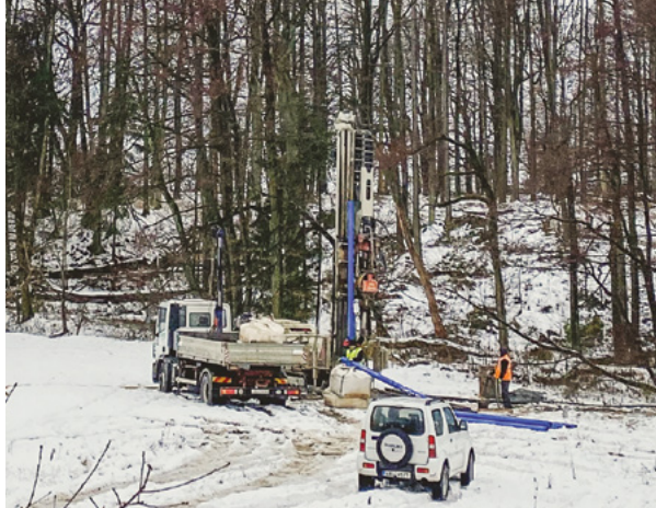
▲ Vrt Martínkov odvrtaný v rámci projektu Podzemní voda v krystaliniku do hloubky 50 m. Foto R. Hadacz.
