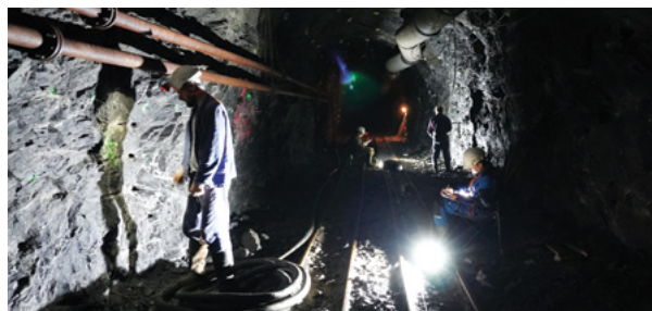
▲ Dokumentace stěny důlního díla v PVP Bukov. Foto O. Švagera.
