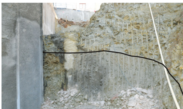
▲ Odlučná hrana starého sesuvu ve stavební jámě při křížení ulic Leitnerova a Kopečná v Brně. Foto O. Krejčí.
