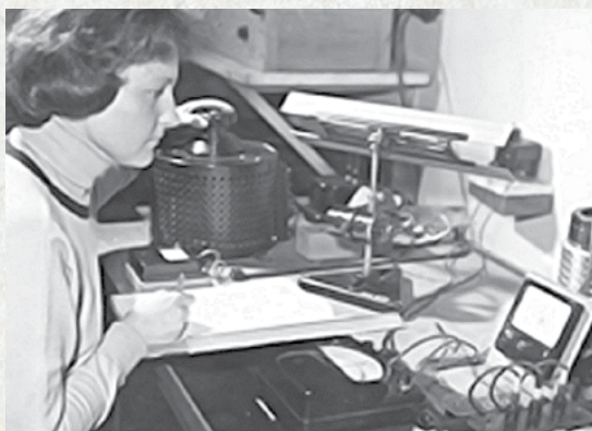
▲ Aparatura DTA k identifikaci jílových minerálů. Foto J. Bárta, 1960.
