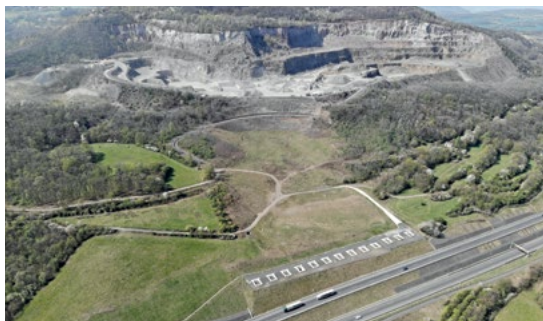
▲ Stabilizovaný sesuv nad dálnicí D8 u Dobkoviček. Foto M. Dostálík.
