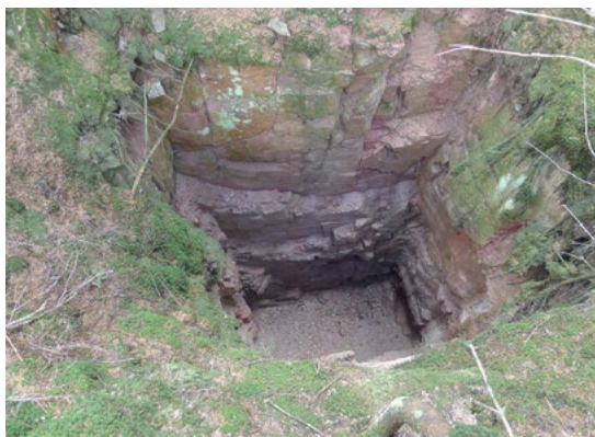
▲ Propad komína na 4. hloubení v blízkosti bývalého Dolu 2 (Schacht II) na ložisku Sn-rud mezi Jelením a Rolavou. Řešeno v rámci Registru starých důlních děl. Foto P. Šír.
