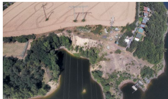
▲ Sesuvné území nad pravým břehem vodního díla Nechranice ohrožuje stožár vysokého napětí. Foto M. Dostálík.
