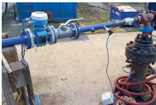
▲ Zhlaví průzkumného geotermálního vrtu PGV LT-1 v Litoměřicích v průběhu injektážních hydraulických zkoušek. Foto J. Holeček.
