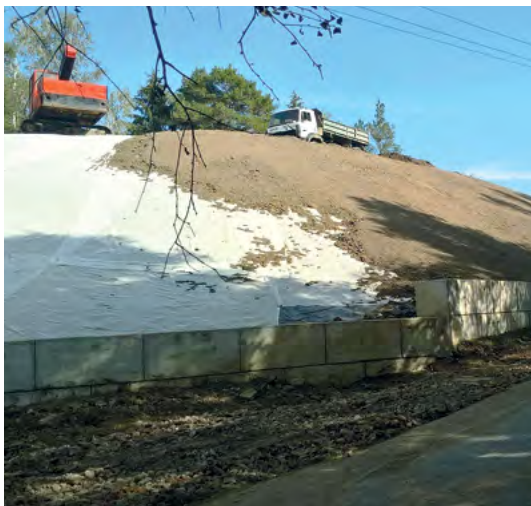
➤ Pokládání fólie při sanačních pracích na odvalu dolu Kuntery (Staročeské pásmo, 16. století) na Kaňku, okres Kutná Hora, v roce 2018.
