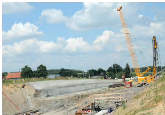
⚡ Stavba tunelu (hloubeného z povrchu) silnice I/58 Příbor – Skotnice u Prchalova. Foto O. Krejčí.
