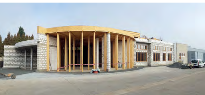
» Rozestavěná budova geotermálního výzkumného centra v Litoměřicích, které vzniká v rámci projektu RINGEN+. Foto J. Holeček.
