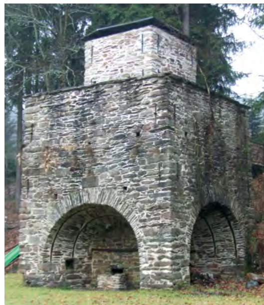
➤ Rekonstruovaná vysoká pec na dřevěné uhlí – Schmalzgrube, Sasko.
