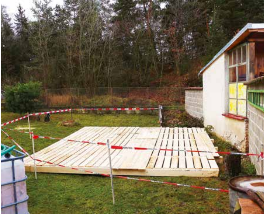
Provizorní zajištění propadu šachty dolu Kuntery (1/2017).
