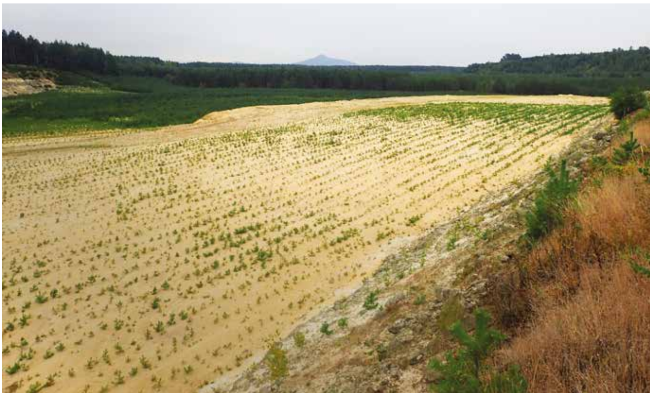
Postup rekultivace po těžbě sklářských a slévárenských písků na ložisku Srní v Libereckém kraji.
