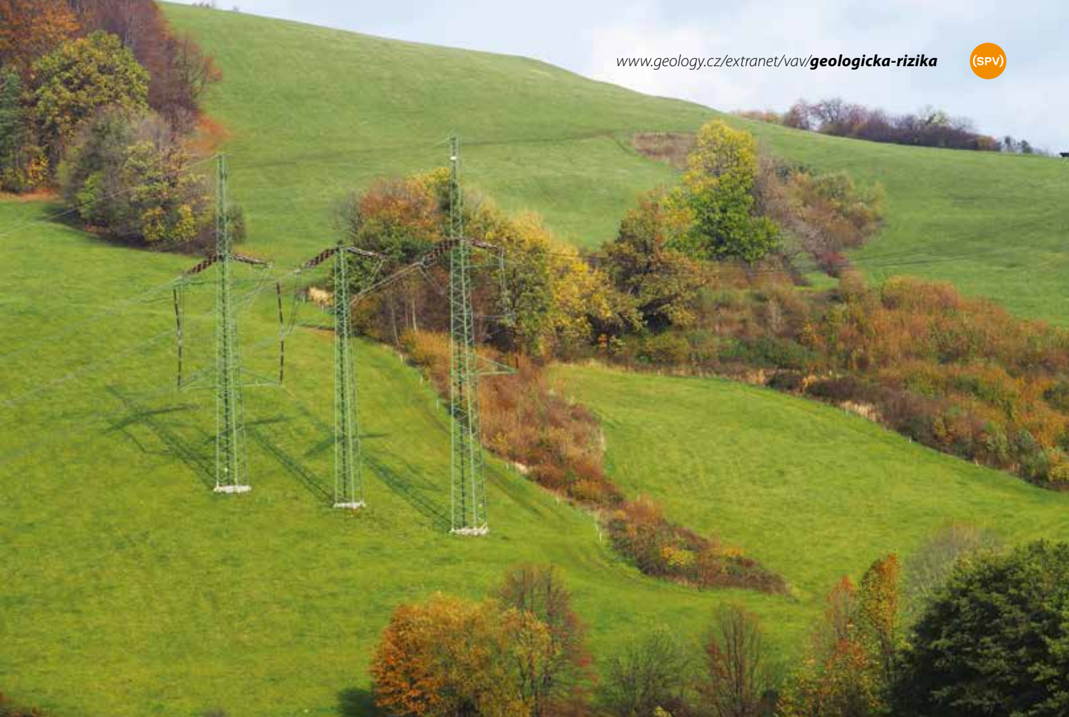
Stožár vedení vysokého napětí u Veřovic. Mezi stožáry zde byl nově identifikován rozsáhlý proudový sesuv.
