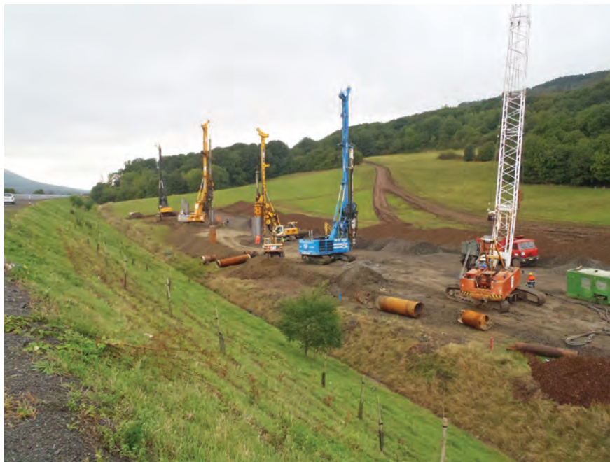
Dálnice D8 (km 57,400). Realizace podzemní šterkové stěny podél náspu pomocí pilotů vrtačných do hloubky 16 m. Foto P. Kycl.
