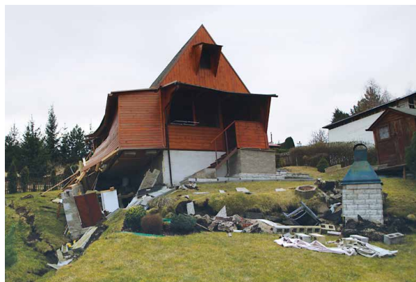
■ Dům v Polákách poškozený sesuvem.
