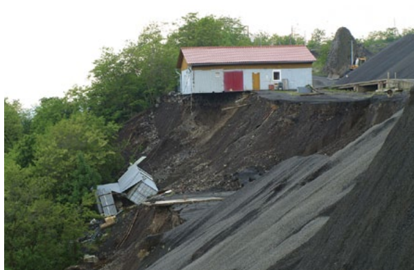
● Škody na majetku vznikly také ve výše položeném lomu. Na hraně sesuvu byly poškozeny budovy zázemí lomu, včetně váhy a deponie drceného kameniva.
