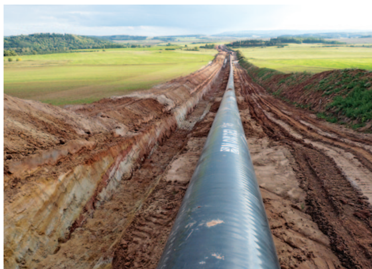
Výkop plynovodu Gazelle východně od obce Kryry. Pohled k jihu směrem do spodní části sedimentů lišského souvrství (svrchní karbon a perm, západní část kladensko-rakovnické pánve). V pozadí masiv tiské žuly. Foto Richard Lojka.
