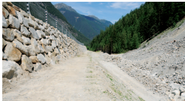
Záchytný prostor za opěrnou zdí, oddělující silnici od skalního sesuvu v Umhausenu v Tyrolsku (foto O. Krejčí).
