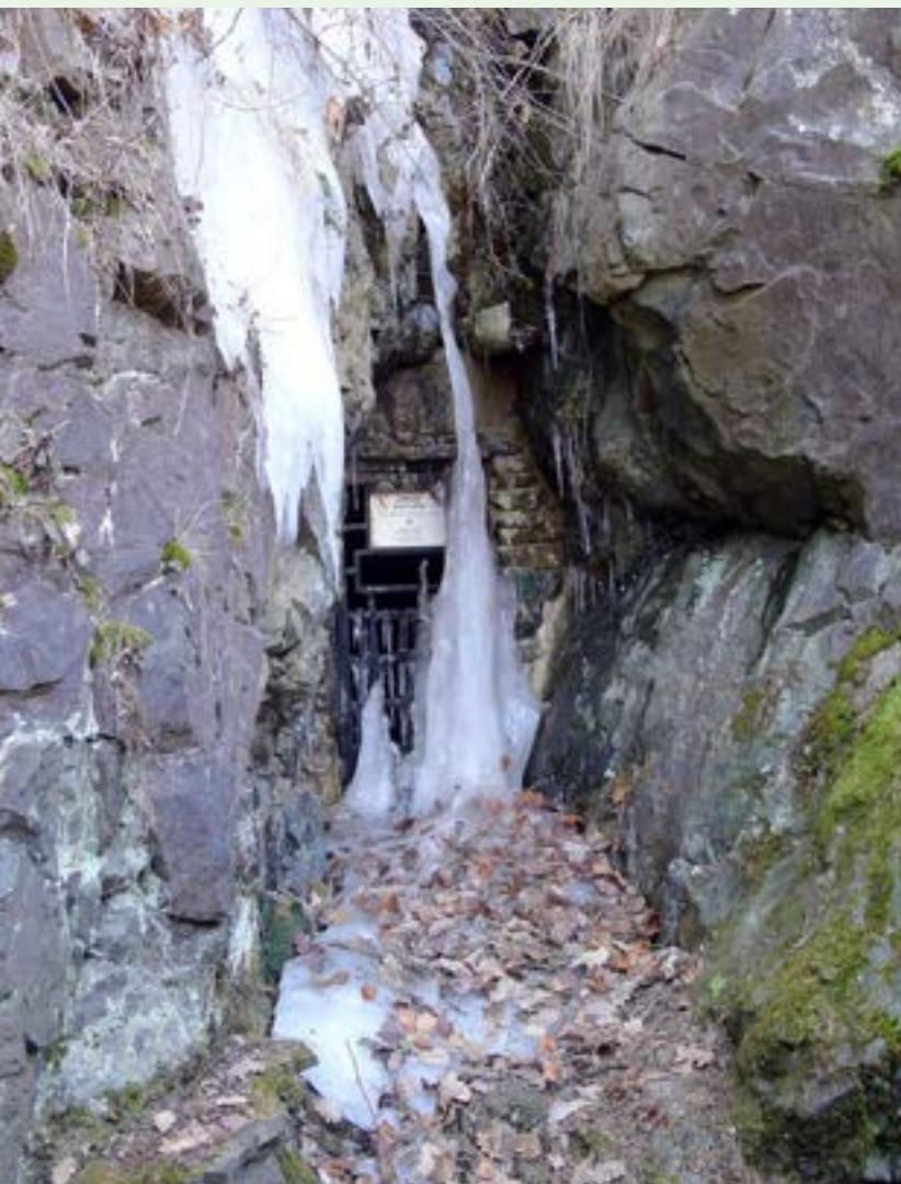
Zajištěný vstup do evidovaného starého důlního díla.
