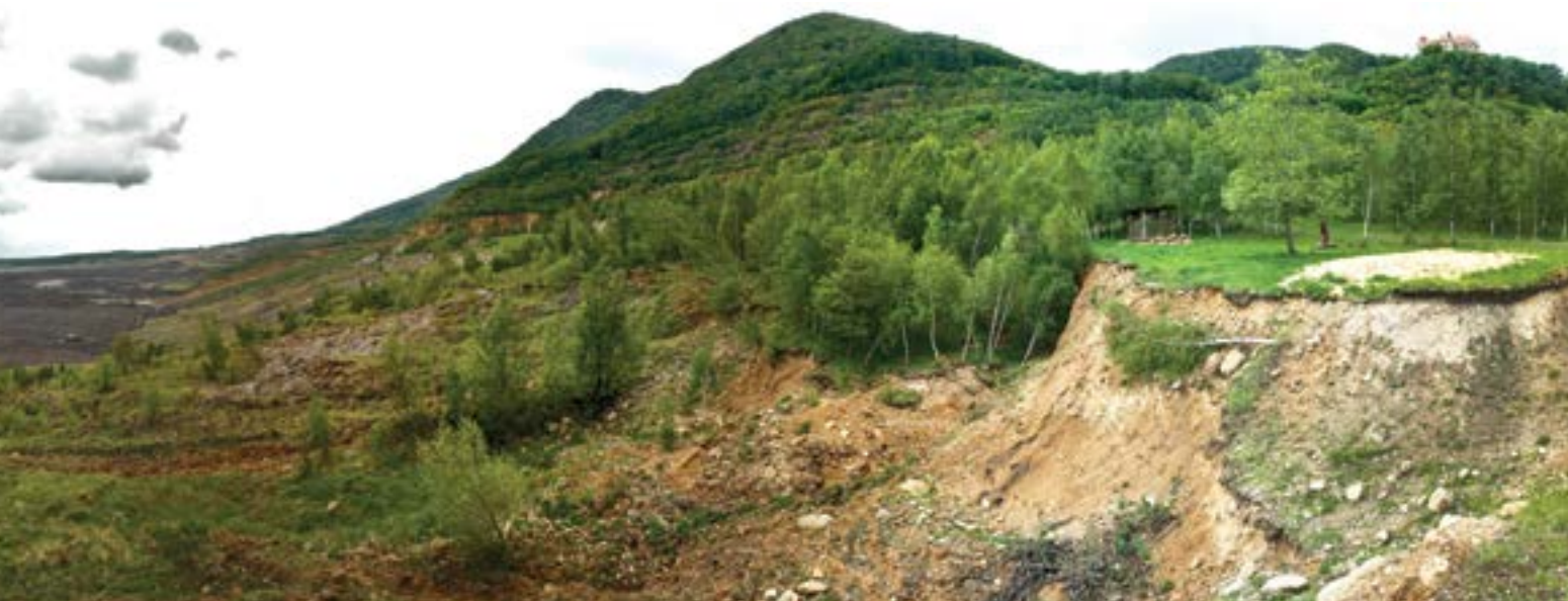
Pohled na východní část odlučné hrany pod zámek Jezeří (foto O. Krejčí).
