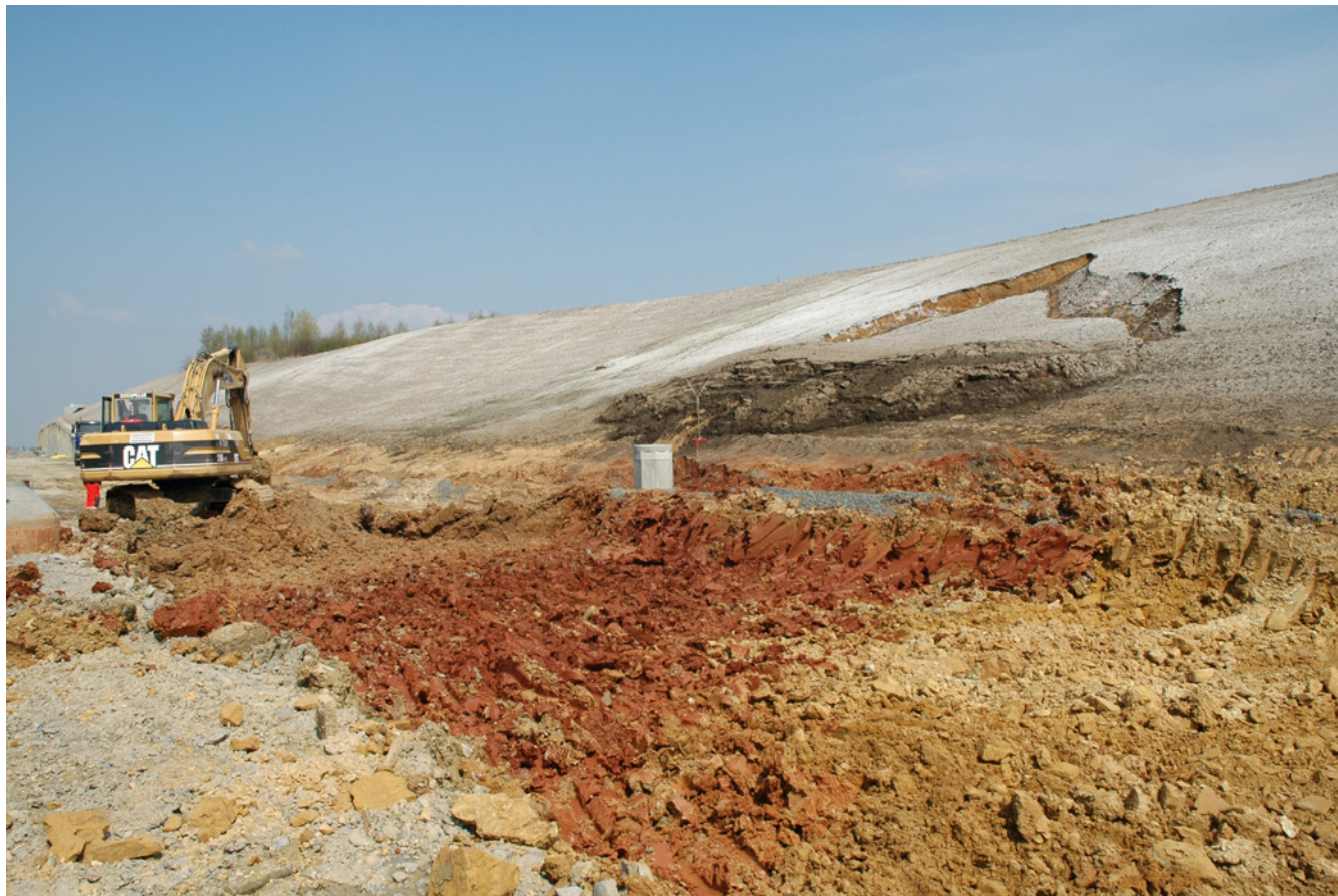
Sanace drobných sesuvů na trase R55 u Otrokovic. Belovežské souvrství magurského flyše (foto O. Krejčí).
