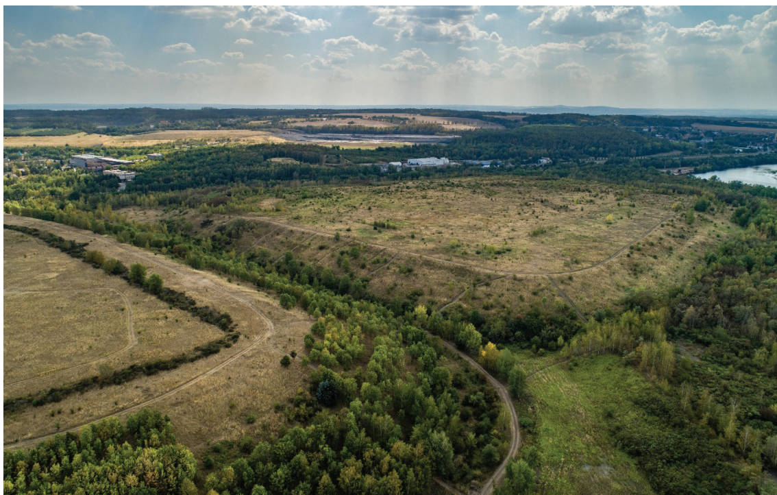
Pohled na stávající podobu odkaliště
