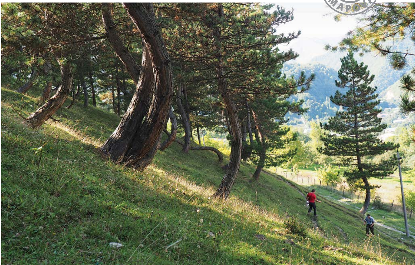
■ Opilý les na sesuvu v blízkosti Kvesheti je dobře viditelným ukazatelem nestability podloží. Stromy mají kmeny zakřivené do různých směrů v důsledku pomalého sesouvání půdy, kterému se postupně přizpůsobují. Foto P. Kycl.
