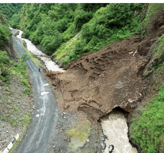
Pozůstatek akumulace laviny, která zablokovala řeku a silnici do Shatili.
