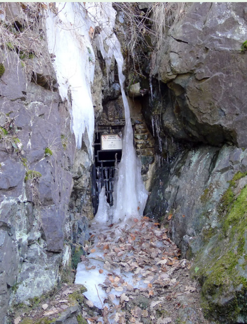
Zajištěný vstup do evidovaného starého důlního díla.
