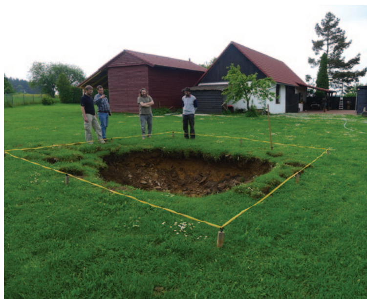
Collapsed depression of the Růženec (Rosenkranz) silver mine shaft in Stará Vožice (Tábor region).
